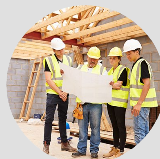
Șantiere de construcții
